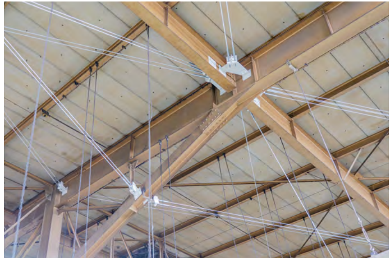
工場操業を止めずに耐震補強
