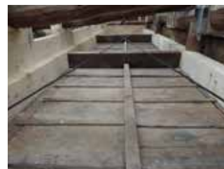
善光寺 経蔵 水平ブレース
