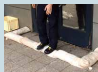
③隙みつけて隙間なく設置する
