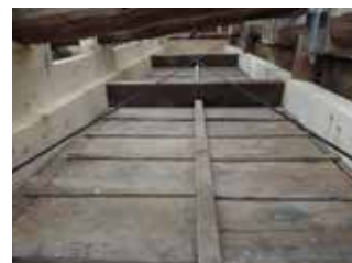
善光寺 経蔵 水平ブレース
