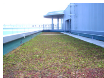
小松精練本社屋上に施工された「グリーンビズ - G」
