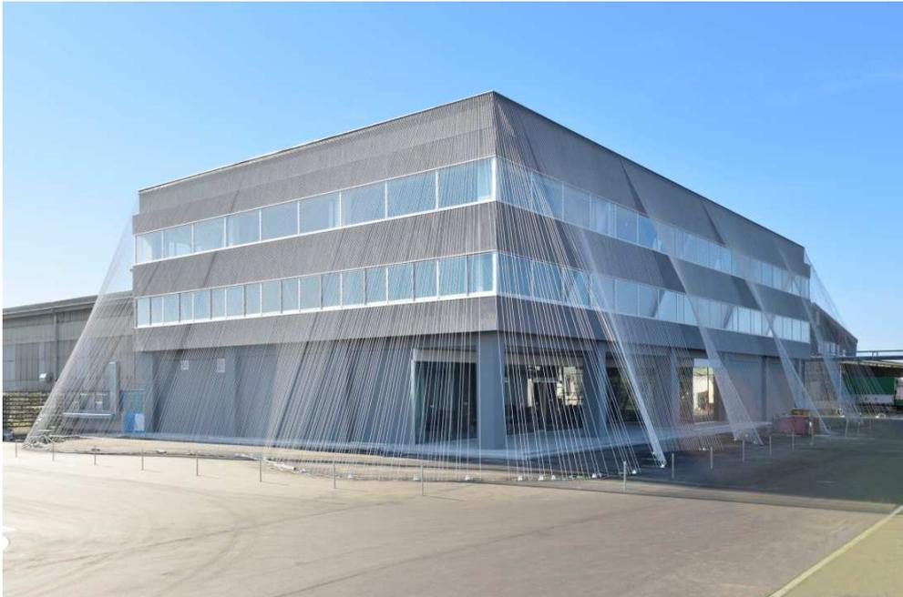
小松精練株式会社（本社：石川県能美市 社長：池田哲夫 以下、小松精練）は、小松精練旧日本社棟の耐震補強に世界初となる熱可塑性炭素繊維複合材料「カボコーマ・ストランドロッド」を採用して改築。この度、ファブリック・ラボラトリー「fa-bo (ファーボ)」として生まれ変わり、2015年11月13日（金）に落成披露会を開催いたしましたのでお知らせいたします。
