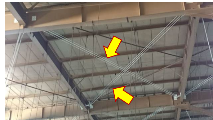
当社第2工場天井(耐震補強)
