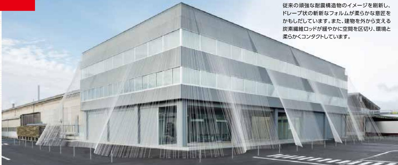
当社は、旧日本社棟の耐震補強に世界初となる熱可塑性炭素繊維複合材料「カボコーマ・ストランドロッド」を用いて改築、新たにファブリック・ラボラトリー「fa-bo(ファーボ)」として生まれ変わり、2015年11月13日に落成披露会を開催しました。
