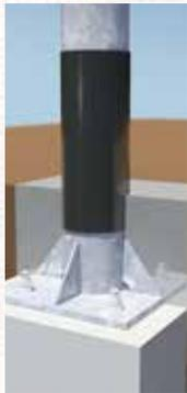
当社は、鋼管を用いた道路標識や信号機などの柱の補強工事向けに、CFRTPによる鋼管柱脚補強材料「カボコーマ・Pシート」と、それを用いた工法を開発しました。
