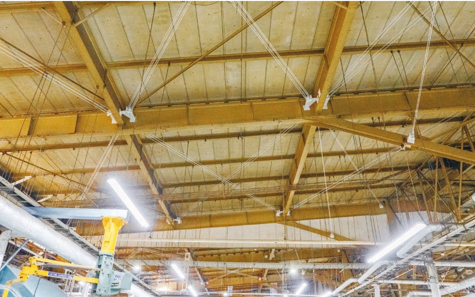
カボコーマを用いて耐震補強を施した第2製造部
