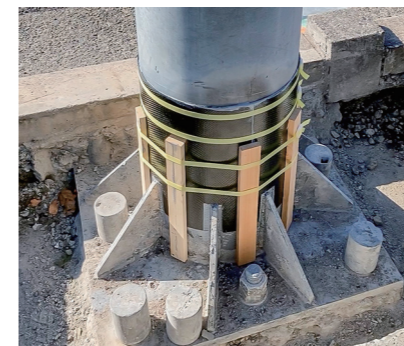
4. CF RTPシートの養生
