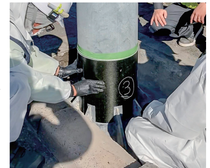
3. CF RTPシート(多層)の貼り付け
