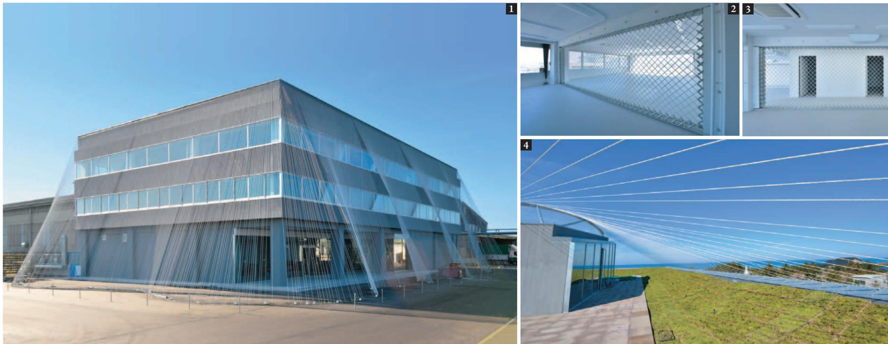
1 外観 建物に張り巡らされた「strandロッド」の張力で、地震時の建物の前後左右の歪みと揺れを抑える。兼六園の雪吊りを思わせる外観。照明時にはオーロラのように見える
